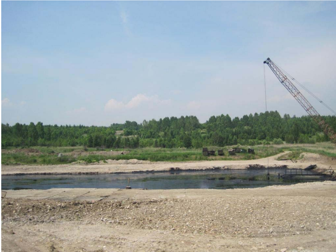
Sanierungs- und Rekultivierungsmaßnahme / Sanační a rekultivační práce
